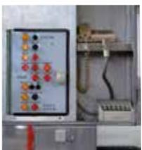
**4.** Der Sicherheitsinspektor bewertet die Situation über die installierte Videokamera vor Ort und aktiviert eine gespeicherte Durchsage für das Personal auf Knopfdruck.
