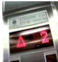
**6.** Die Brandmeldezentrale übernimmt die Liftsteuerung und verhindert, dass die Aufzüge in den betroffenen Bereichen stehen bleiben, und/oder bewegt den Lift in eine zuvor festgelegte Endposition.
