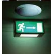
**7.** Das ENS löst automatisch eine Durchsage zur sofortigen Evakuierung des betroffenen Bereichs aus.
